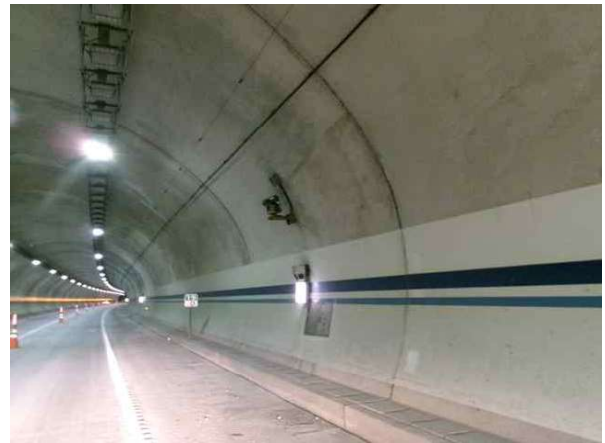
라이닝 우측벽 상태양호-문산방향
