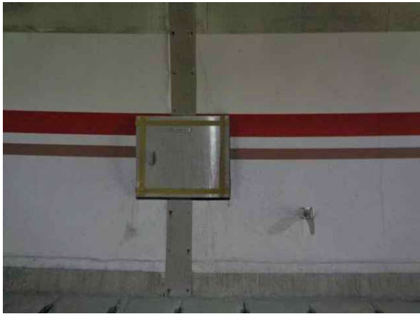
라이닝 S19 측벽부 균열( C_w=0.3\text{mm} 미만)-문산방향
