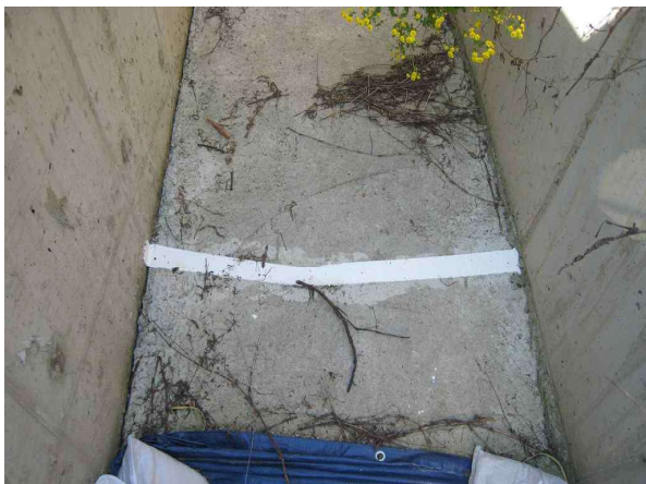
시점측 갭문 배수로 균열 보수완료-문산방향
