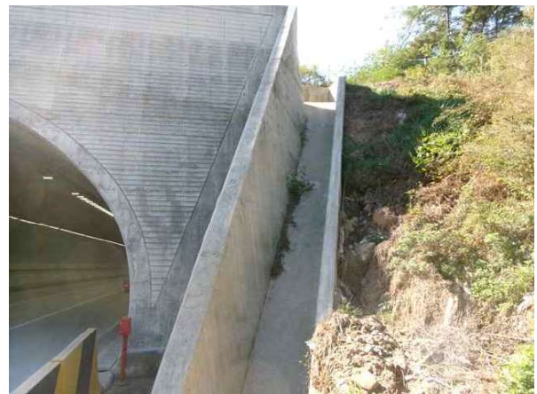
종점측 갭문 배수로 전경-서울방향
