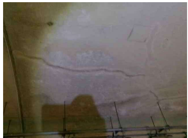
라이닝 S40 천단부 재균열( Cw=0.3\text{mm} 이상)-서울방향
