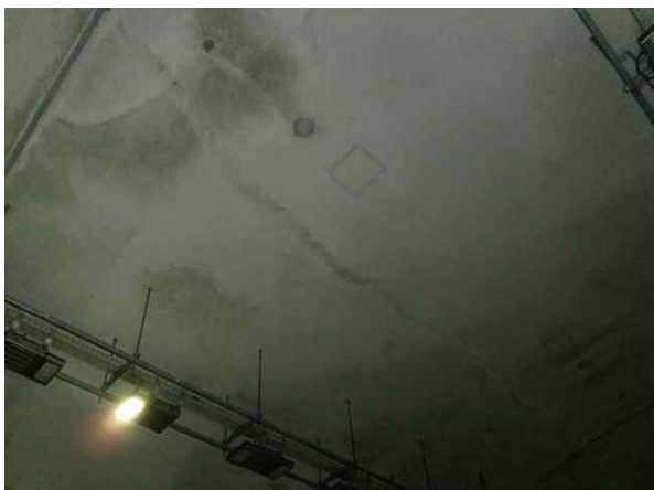
라이닝 S36 천단부 재균열( Cw=0.3\text{mm} 미만)-서울방향
