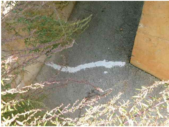
시점측 갭문 균열보수-서울방향
