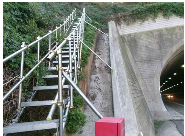
중점측 갭문 배수로 상태양호-문산방향
