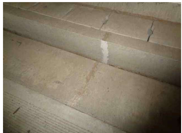
공동구 S08 균열 보수완료-문산방향
