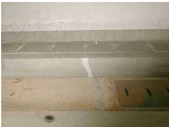
포장부 S27 균열 보수완료-서울방향
