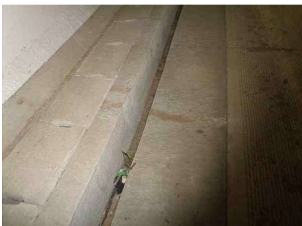
포장부 S10 갯길측 균열 보수완료-문산방향
